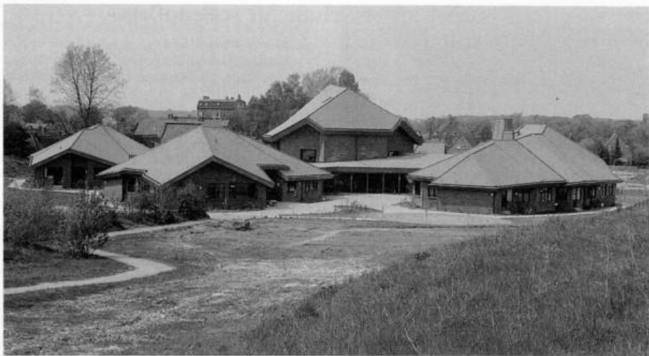
Gesamtansicht von Osten, Oberstufe, Mittelstufe, Saal, Unterstufe
