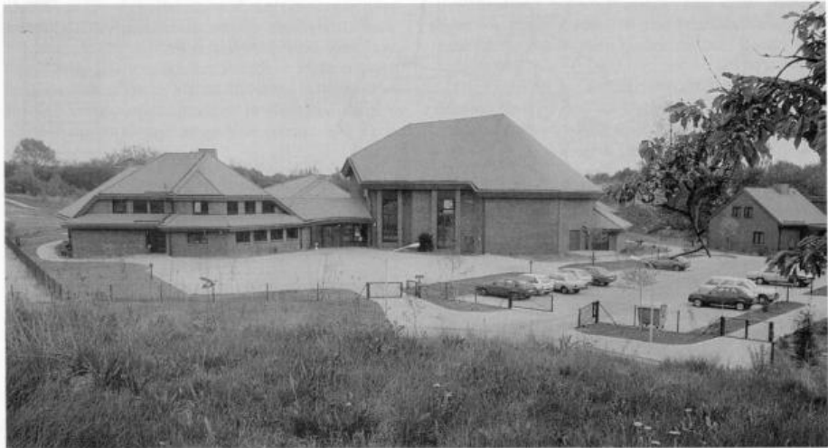
Gesamtansicht von Nordwest, rechts Hausmeisterhaus
